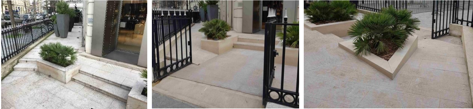
Création d'un accès pour usagers en fauteuil roulant
